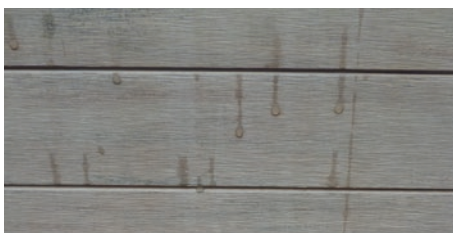
Fleckenbildung durch von Regen angelöste Partikel
