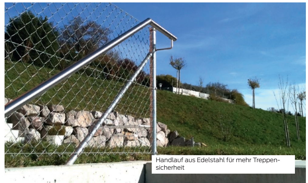
Handlauf aus Edelstahl mit Rundrohrpfosten in Neigung versetzt, zusätzlich mit Drahtseilen aus Edelstahl für mehr Sicherheit
