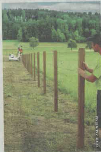
Wichtig: Der Kontrollblick bei der Zaunmontage
